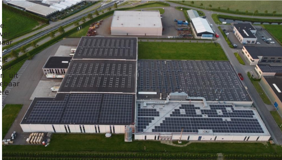
Op het dak van de meubelfabriek in Hulst (NL) waar de City Line kasten geproduceerd worden, liggen 3.000 zonnepanelen. Deze zonnepanelen zorgen voor een opbrengst van de volledige jaarbehoefte van de fabriek.
